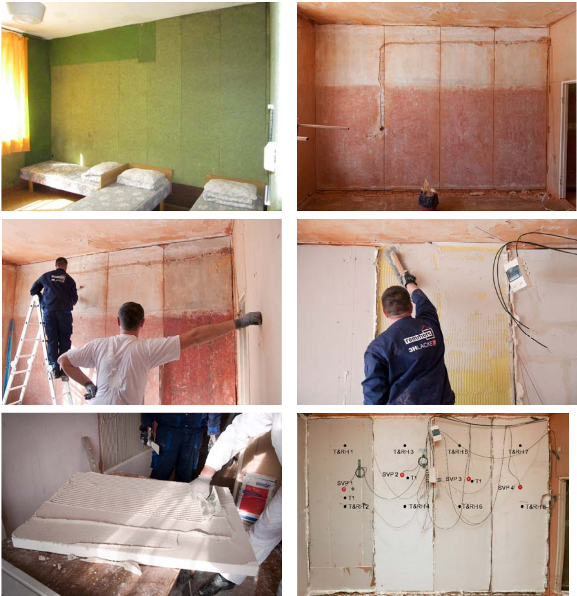
Joonis 2 Soojustuse ja mõõteseadmete paigaldus.
